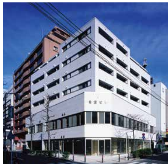
日吉ビル The Hiyoshi Building
