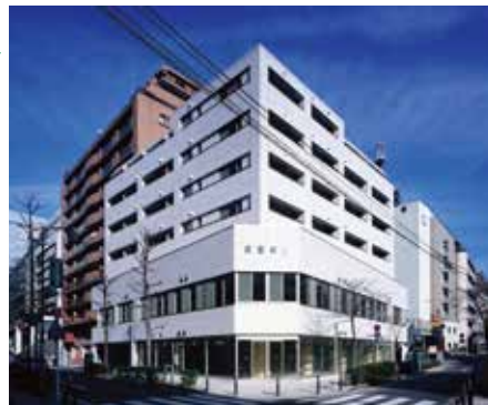
日吉ビル The Hiyoshi Building
