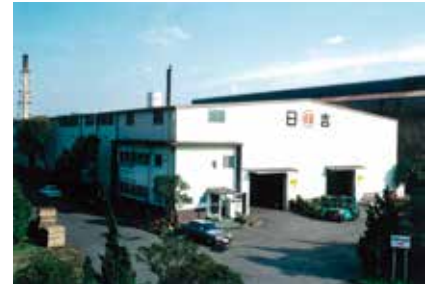
君津合金鉄倉庫 Kimitsu ferroalloy warehouse
